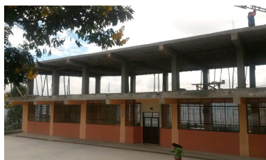
Construction de classes
